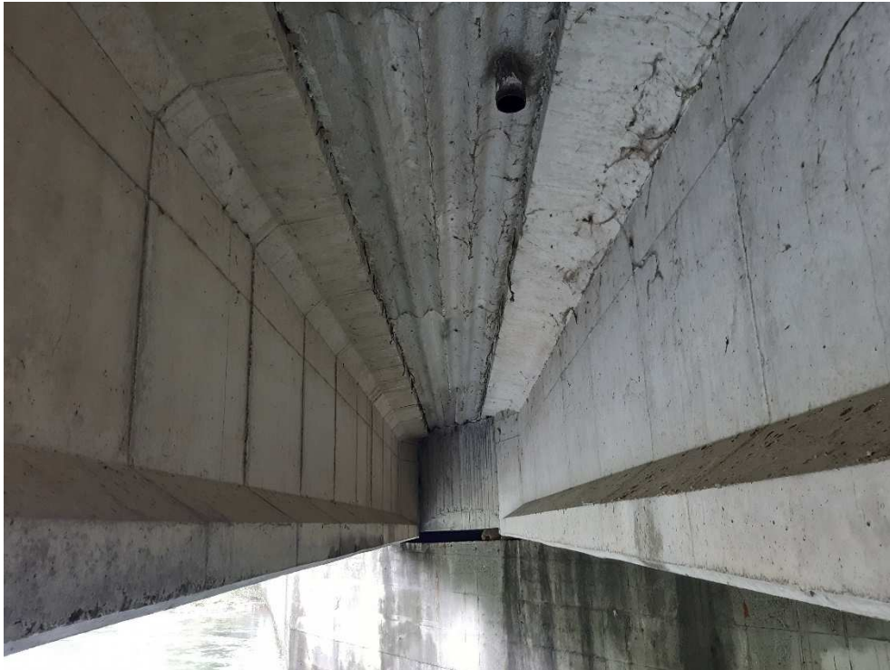
Figure 3 : présence évacuation d'eau à travers le trottoir en aval, coffrage perdu fibrociment
