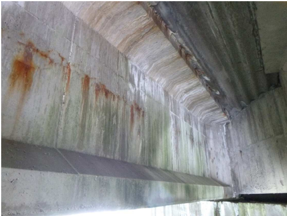
Figure 30 : pt3-points de corrosion en semelle supérieure, traces de calcite, fissure longitudinale sur 8ml avec traces de corrosion – coté RD amont
