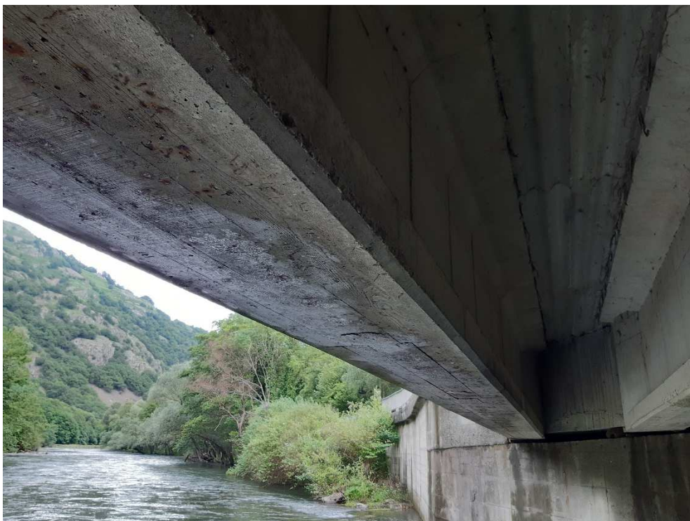
Figure 50 : pt8 – traces d'écoulement d'eau côté extérieur et en sous-face, sur la longueur de la poutre, éclats béton en sous face de poutre – côté RD aval
