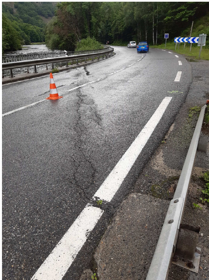
Figure 52 : joint de chaussée non taillé, fissures longitudinales – RD
