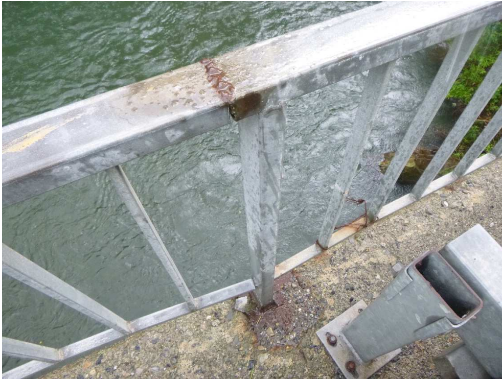
Figure 65 : corrosion de la soudure entre garde-corps
