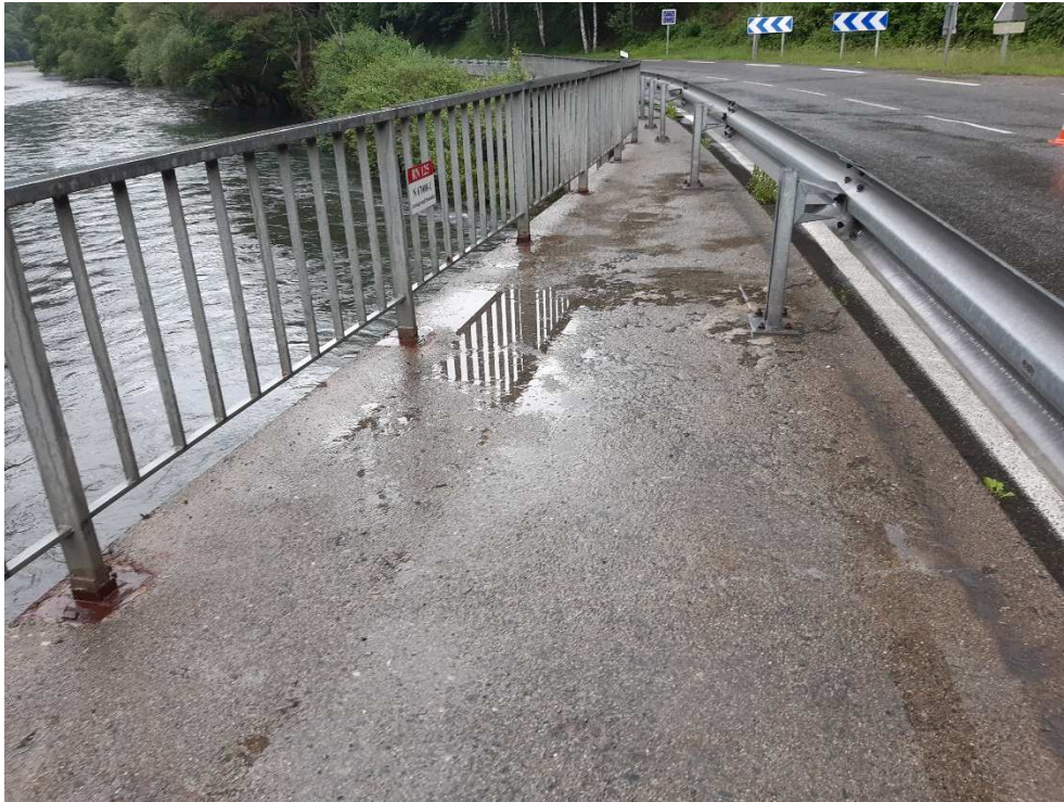
Figure 7 : zone de flaches, trottoir asymétrique, prolongement des glissières et vue garde-corps – Aval
