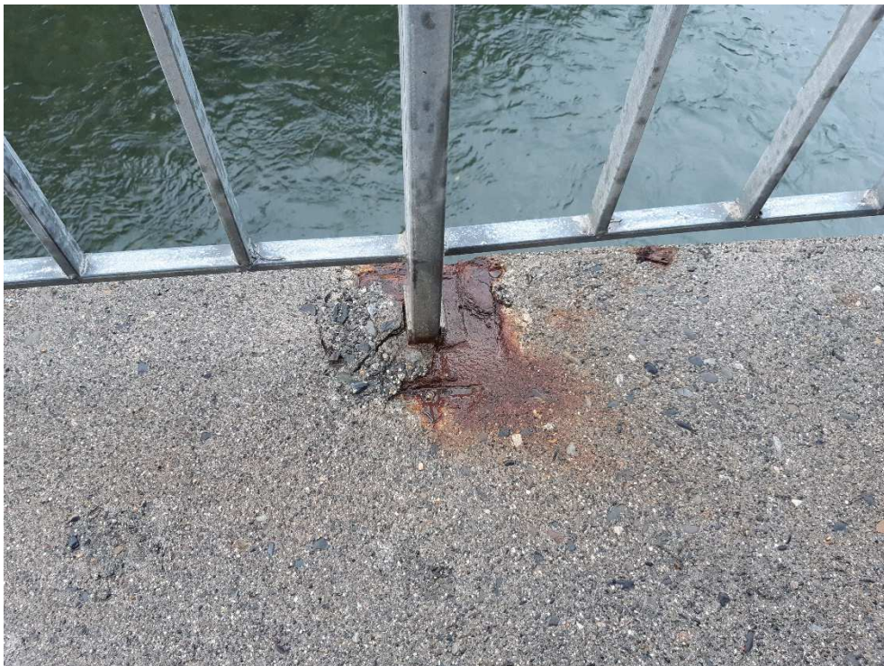
Figure 66 : corrosion des platines de fixation, éclats de béton, corrosion foisonnante – généralisé
