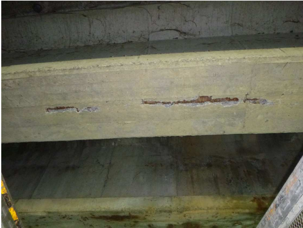
Figure 67 : pt6 - gaine apparente après purge au marteau d'auscultation
