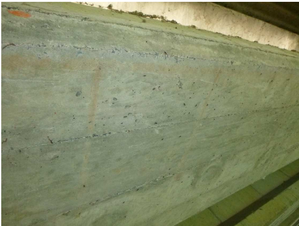
Figure 70 : traces de rouille généralisées sur pt 1-5-6 et 7
