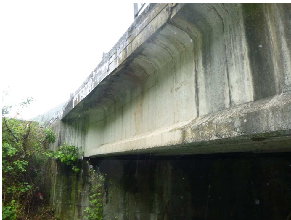
Figure 28 : pt1-traces d'humidité et d'écoulement d'eau, oxydation en semelle supérieure – RG aval
