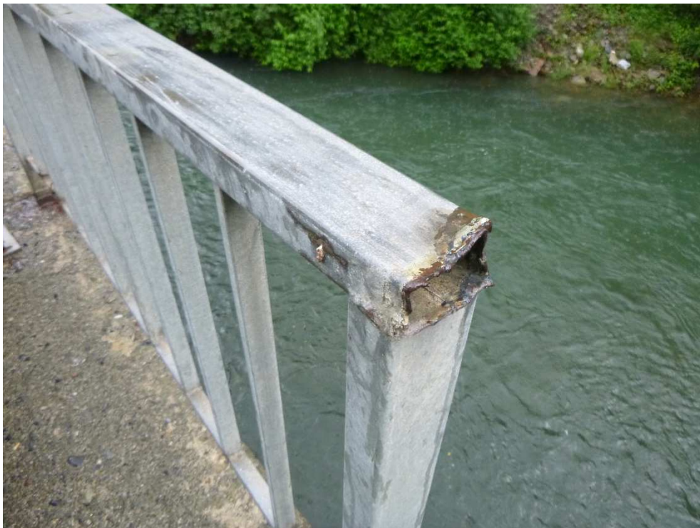
Figure 64 : Garde-corps rompu – RG amont
