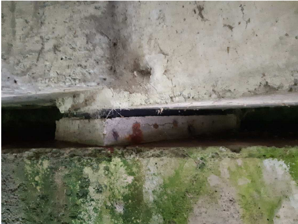
Figure 19 : appareil d'appui fissuré en hauteur – RG pt6
