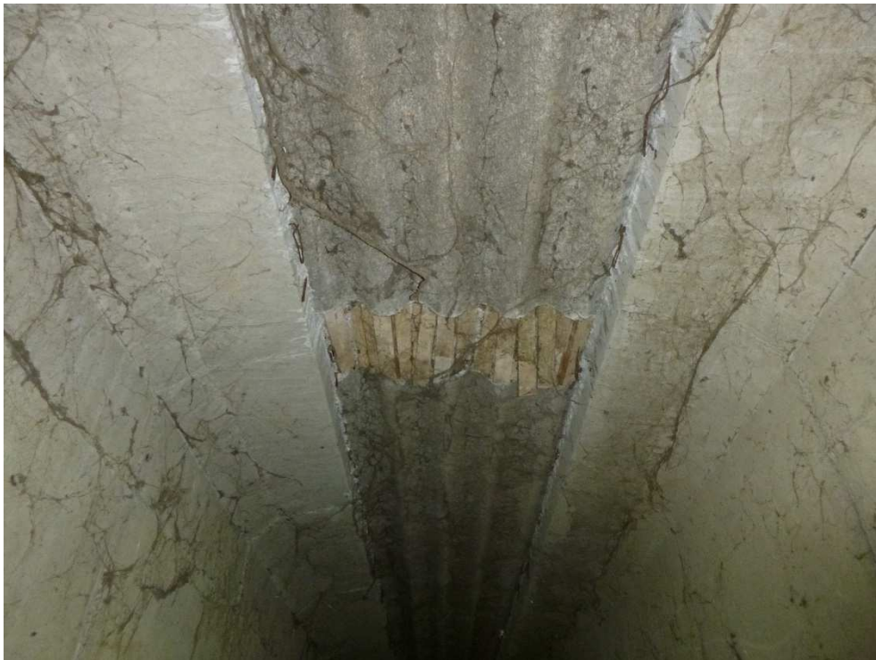
Figure 22 : coffrage de fortune en bois entre pt4 et 5
