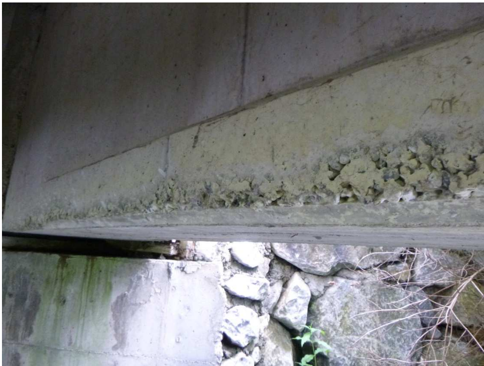
Figure 24 : pt1-nid de cailloux / ségrégation sur semelle inférieure coté RD et RG/aval
