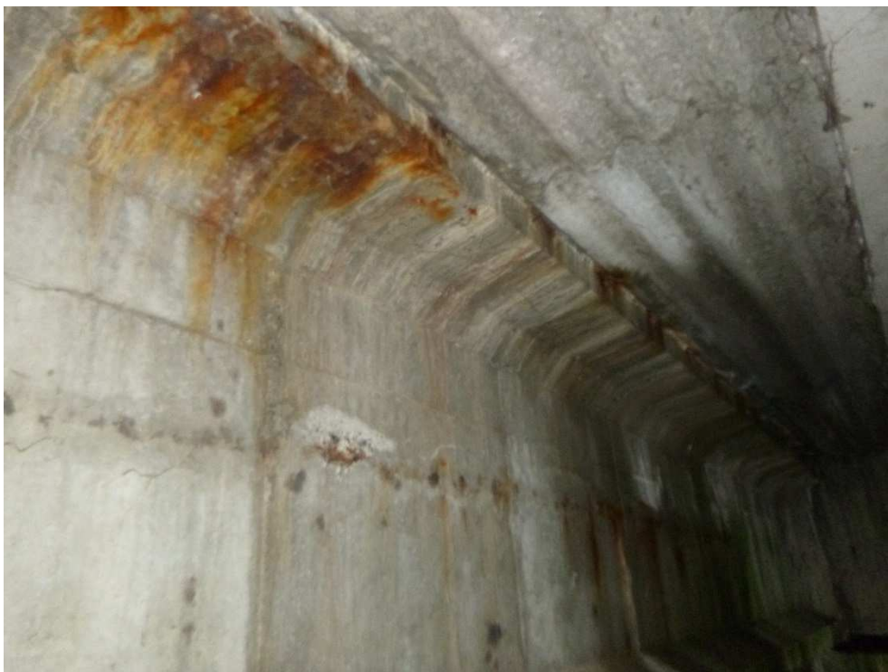
Figure 33 : pt3 – fissure longitudinale sur âme de la poutre, éclat béton avec acier apparent corrodé, traces de rouille et de corrosion sur la semelle supérieure, sur environ 8ml – côté RD amont
