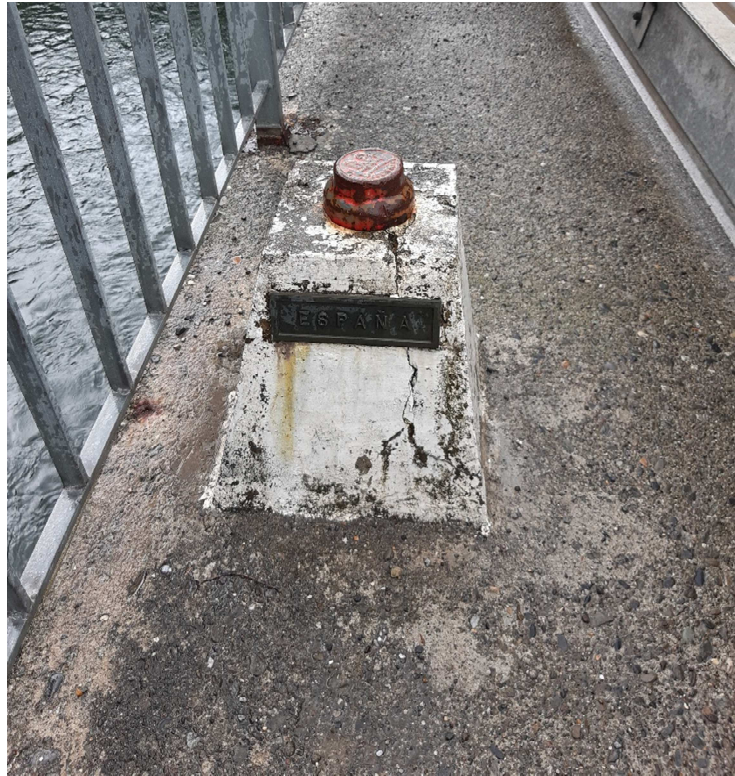
Figure 59 : Borne délimitation frontière fissurée – amont
