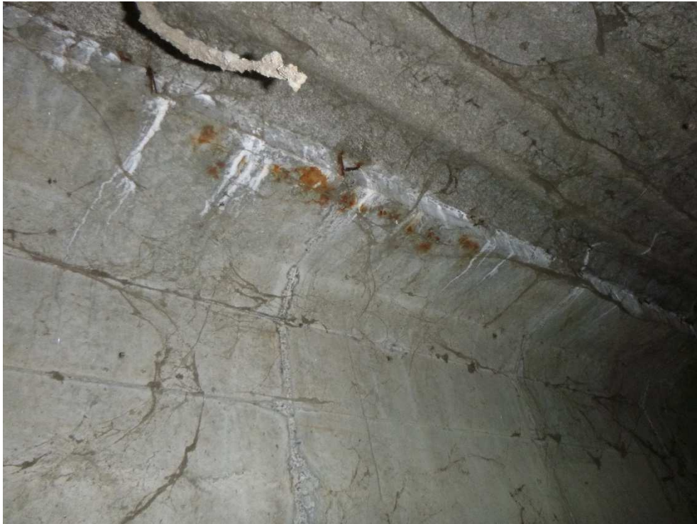
Figure 37 : pt4 – Présence de corrosion en semelle supérieure, traces de calcite sur environ 8 ml– coté RD aval
