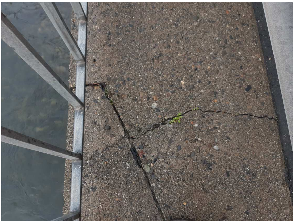
Figure 58 : Fissure transversale, altération du joint d'étanchéité, désagrégation de surface - RD aval
