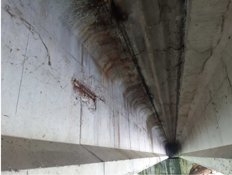
Figure 41 : pt5-traces de calcite, d'oxydation, fissure longitudinale généralisée sur la semelle supérieure, acier apparent corrodé et éclat béton sur l'âme – milieu de portée, coté aval
