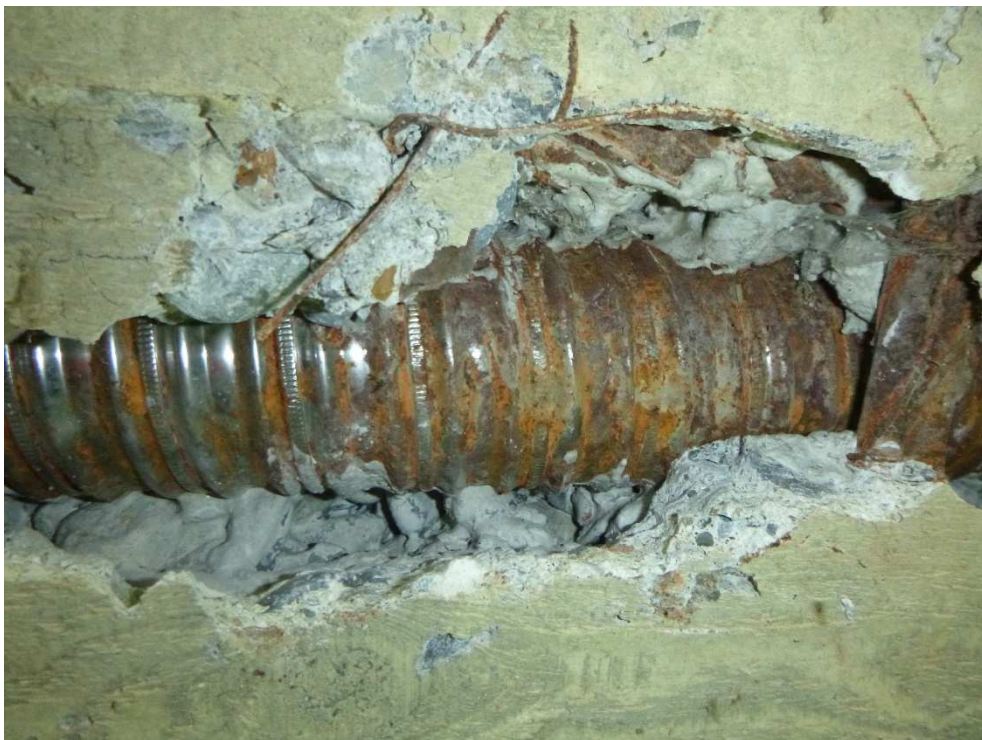
Figure 68 : pt6 - gaine apparente après purge au marteau d'auscultation
