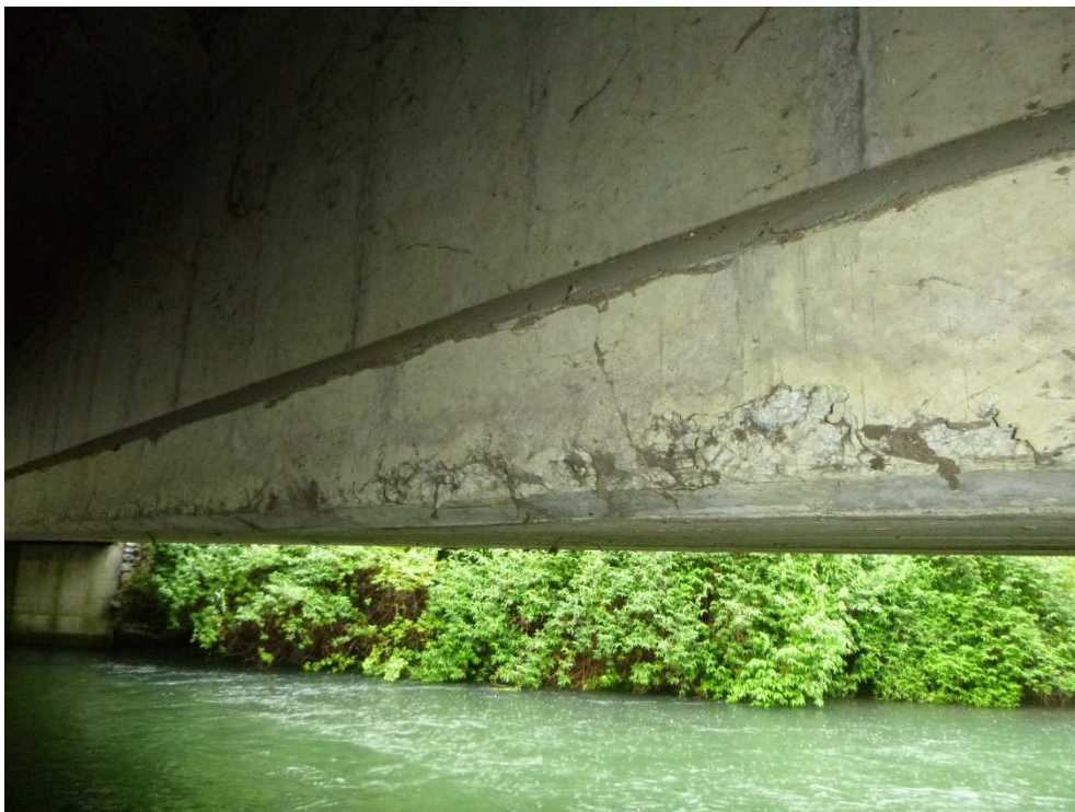
Figure 38 : pt4 - nid de cailloux, défaut de coffrage – coté RG amont
