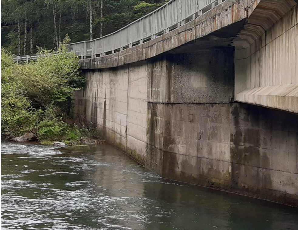
Figure 15 : nids de cailloux, traces d'humidité, mousse, éclat béton - RD
