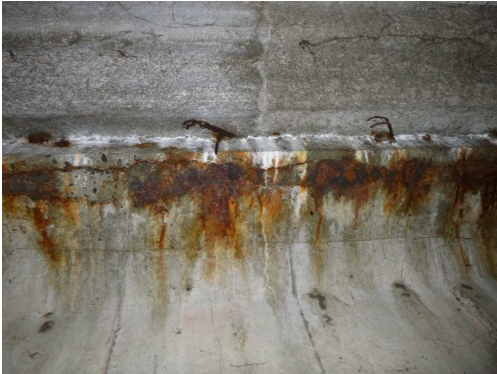
Figure 35 : pt3 - Corrosion en semelle supérieure, traces de calcite et fissure longitudinale avec éclat béton sur 10ml- coté RG amont
