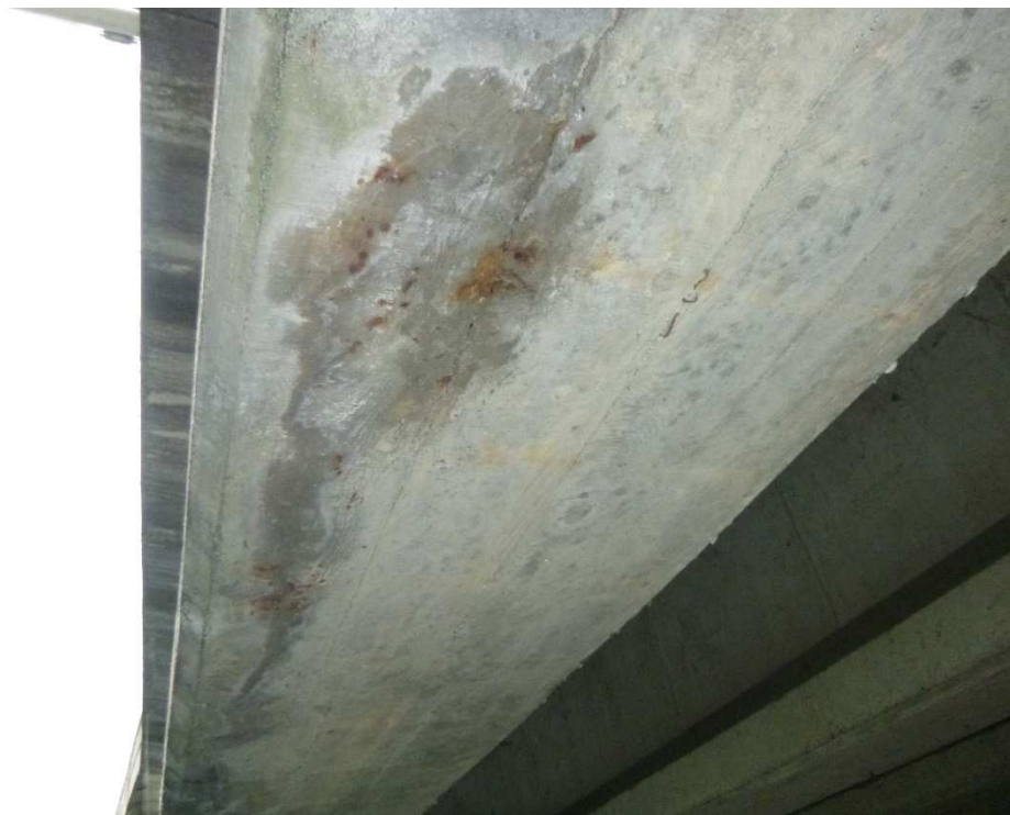
Figure 27 : pt1-traces de corrosion, humidité, milieu de portée - aval
