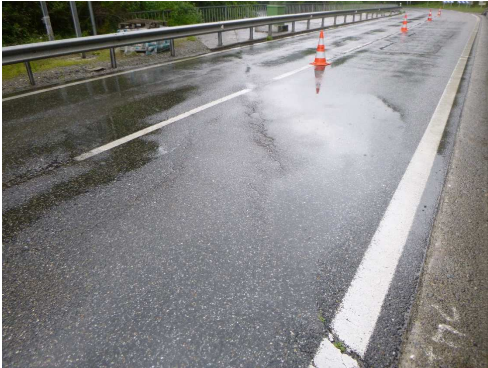
Figure 51 : joint de chaussée absent, fissures longitudinales – RG
