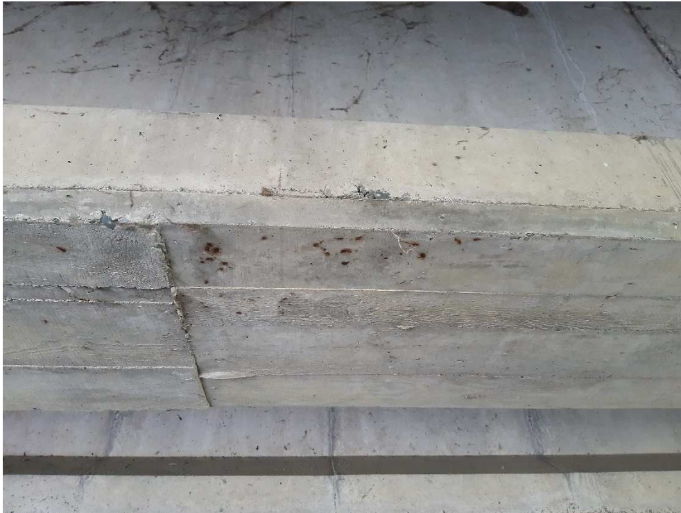
Figure 39 : pt5 – points de d'oxydation en sous-face – coté RD aval
