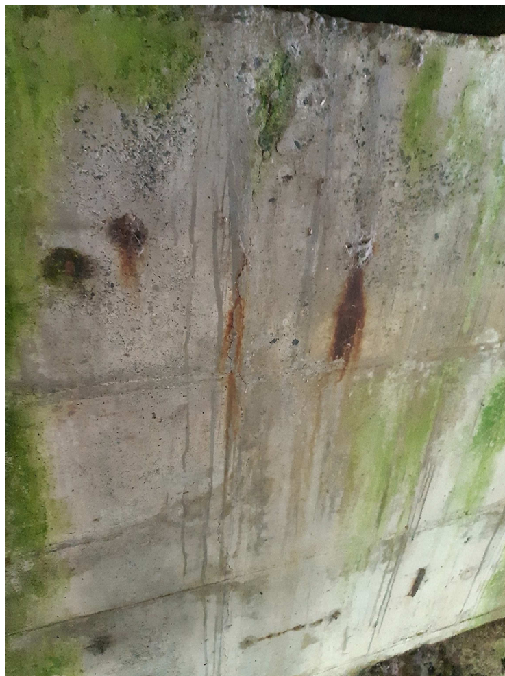
Figure 18 : traces d'oxydation et fissures verticales - RG
