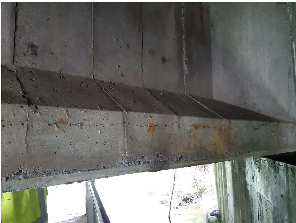
Figure 46 : pt5 – fissure longitudinale sur semelle inférieure sur 2.0ml
