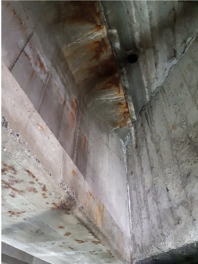
Figure 47 : pt5 – fissures sur âme, semelle inférieure et supérieure, traces d'oxydation, corrosion, humidité de l'hourdis autour de l'EP, traces de calcite – à l'appui, RG coté aval
