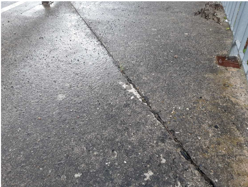
Figure 60 : Altération du joint de chaussée, désagrégation de surface - RD
