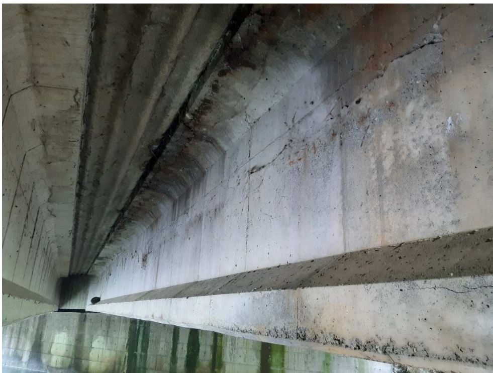
Figure 43 : pt5 – traces d'humidité, de calcite en partie supérieure. Fissure longitudinale avec éclat de béton sur 1.10ml - coté aval
