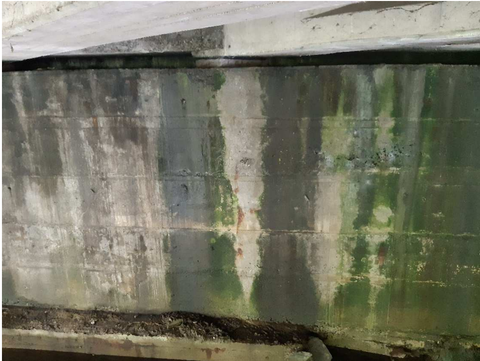
Figure 17 : ségrégation, mousse, humidité - RG
