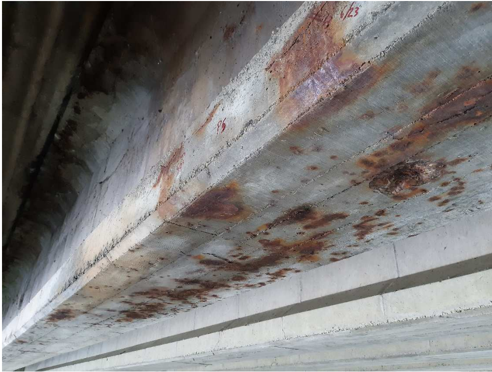
Figure 45 : pt5 – sous-face de poutre et semelle supérieure, points d'oxydation, traces de corrosion, éclats béton avec aciers apparents - coté RG aval
