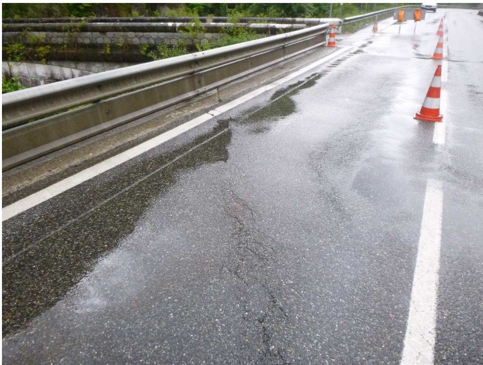
Figure 54 : fissures sur chaussée entre les zones de roulement – sens Espagne/France
