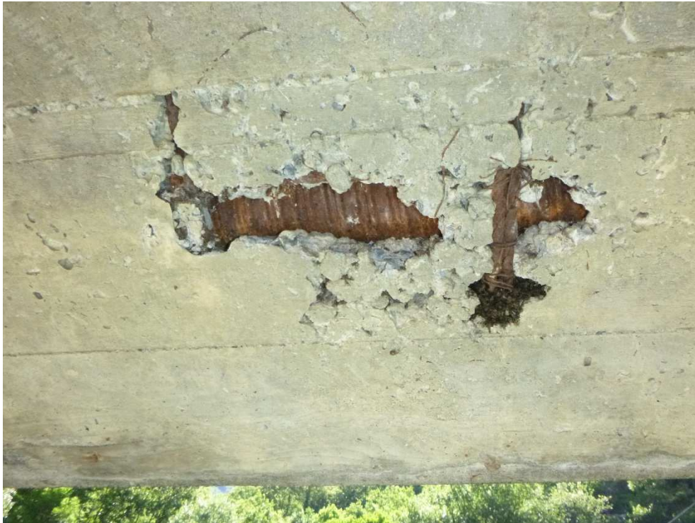
Figure 69 : pt1 - gaine apparente après purge au marteau d'auscultation
