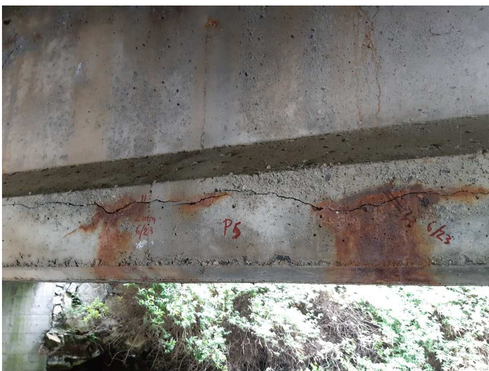
Figure 44 : pt5 – fissure longitudinale sur semelle inférieure sur 2.00 ml d'ouverture comprise entre 1.5 mm et 2 mm – coté RG aval
