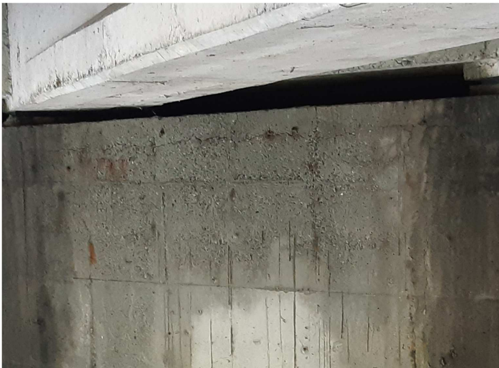
Figure 12 : fissure longitudinale - RD
