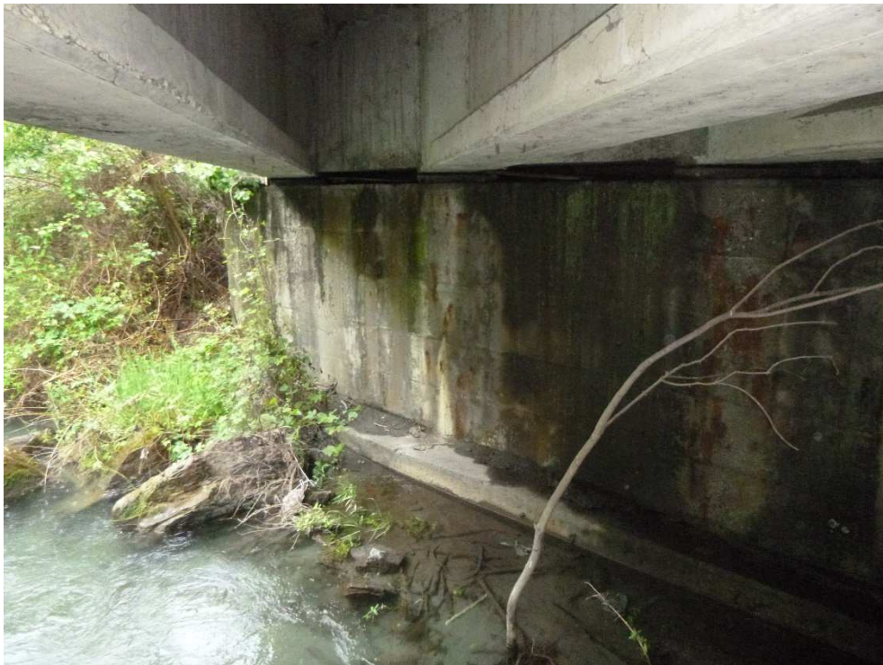
Figure 20 : forte présence d'humidité, mousses et traces d'oxydation visibles - mur de front RG
