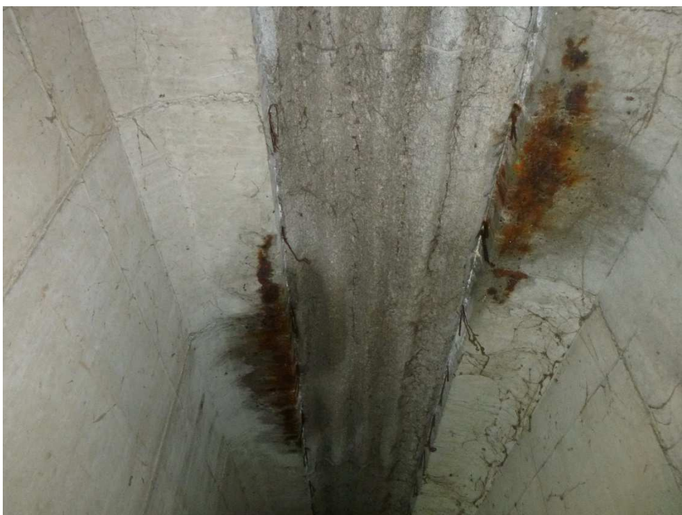
Figure 34 : pt2 et pt3 – présence de calcite, d'humidité et de corrosion en sous-face des semelles supérieures – milieu de portée des poutres.
