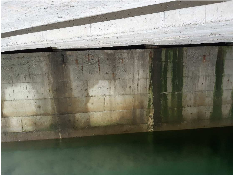
Figure 11 : présence d'humidité, mousse, ségrégation granulaire, points de rouille - RD
