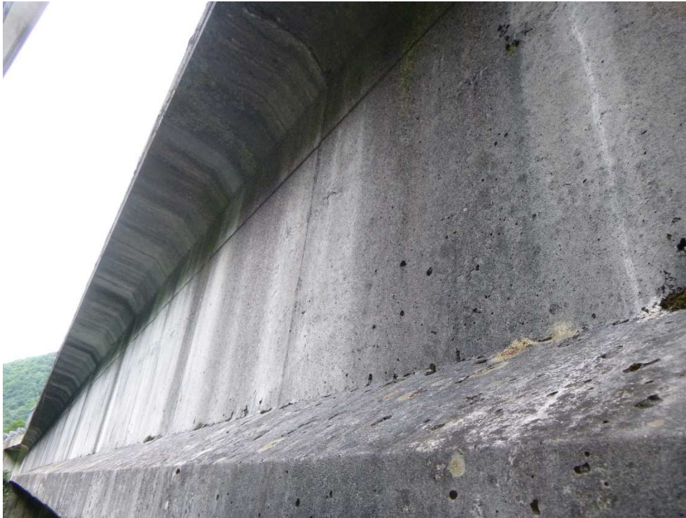
Figure 23 : pt1 - traces d'écoulement d'eau coté extérieur – amont
