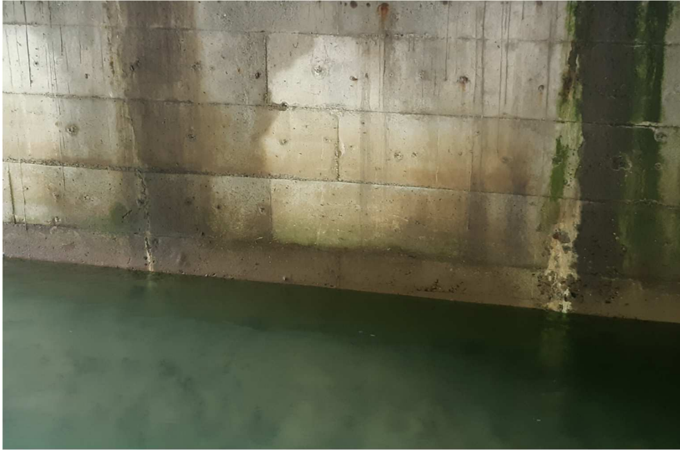
Figure 13 : fissures verticales et présence de calcite dans la zone de marnage - RD
