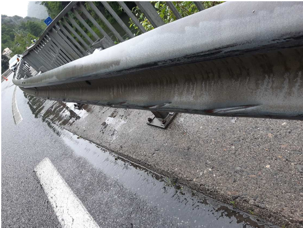
Figure 62 : traces de frottement sur glissière de sécurité – RD aval
