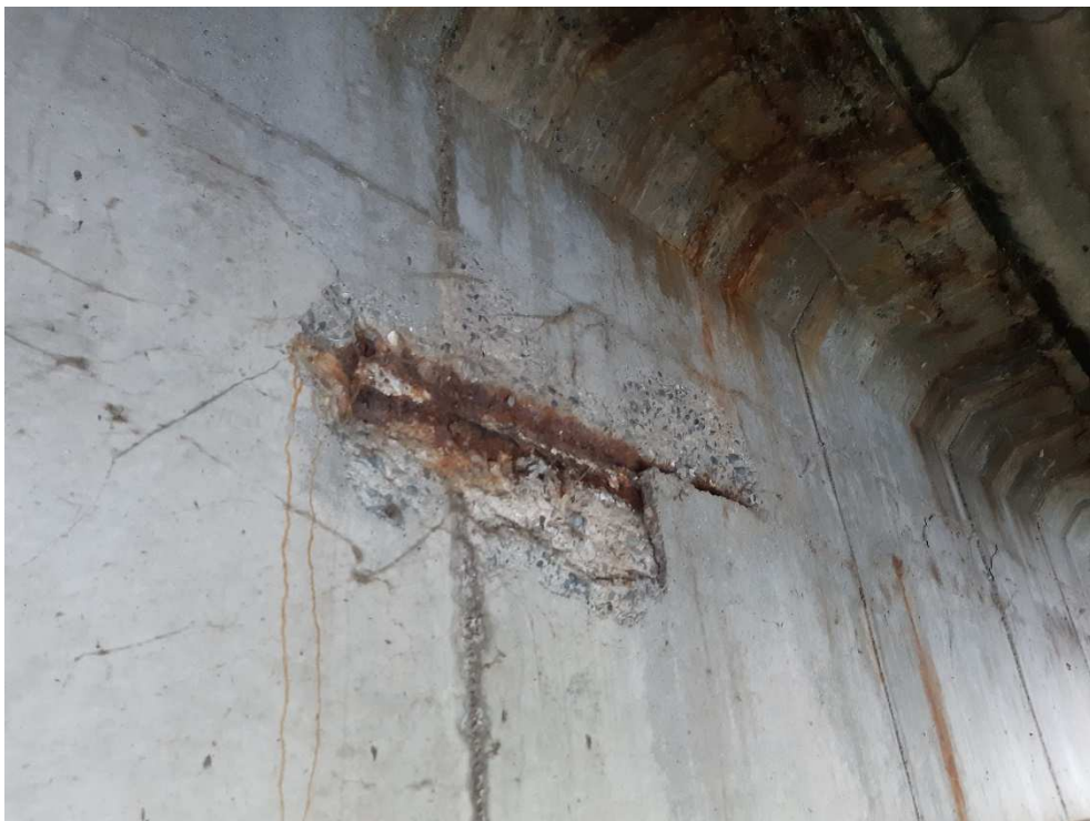
Figure 42 : pt5 – vue rapprochée de l'acier apparent corrodé – milieu de portée, coté aval
