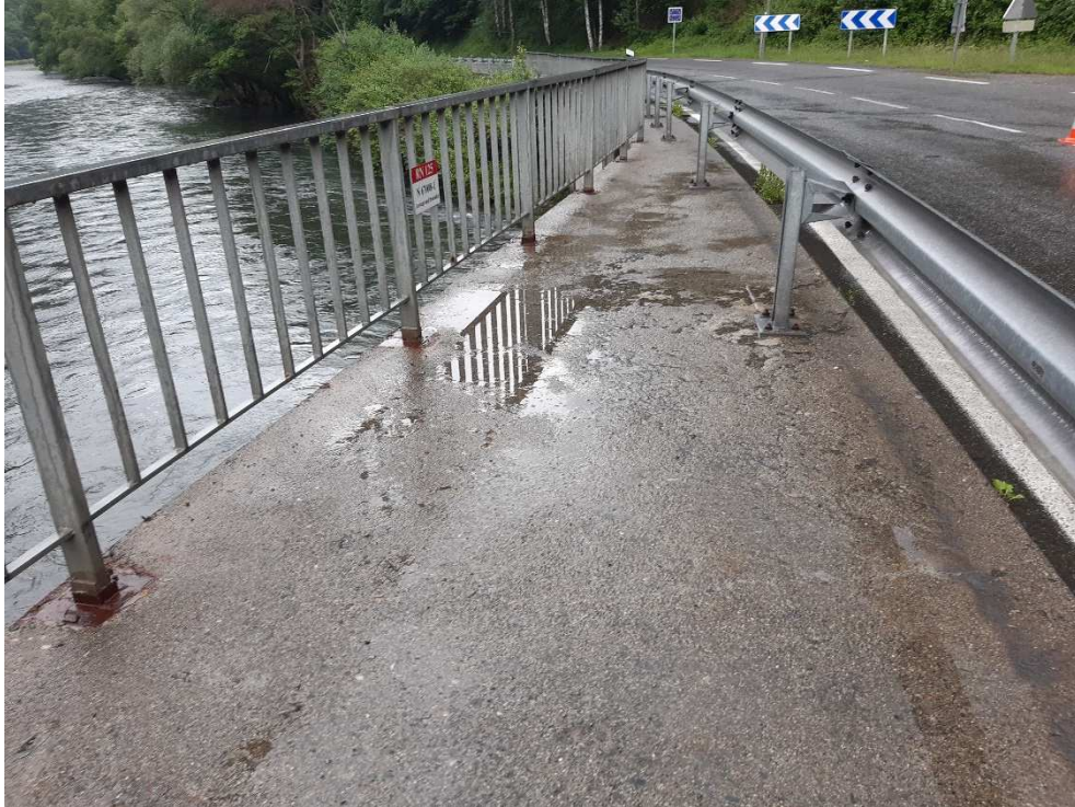
Figure 55 : zones de flaches, désagrégation de la surface – aval
