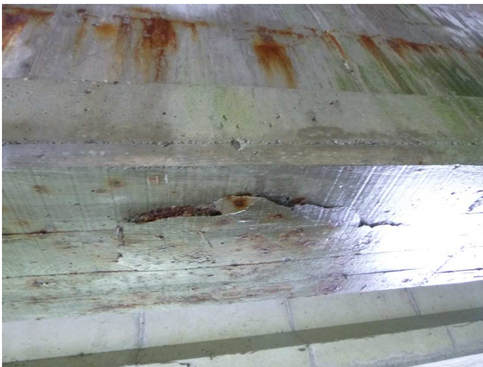
Figure 32 : pt3-éclat béton en sous-face avec traces de corrosion, présence d'eau et d'humidité - côté RD amont
