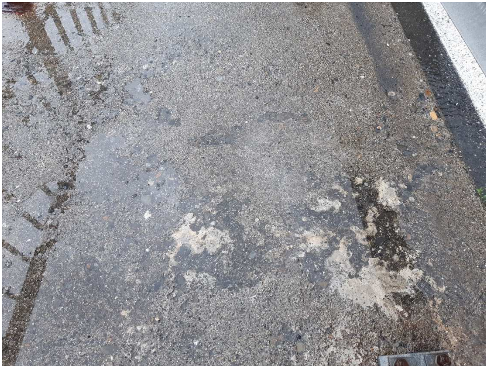
Figure 56 : zoom sur flaches et désagrégation de surface – aval
