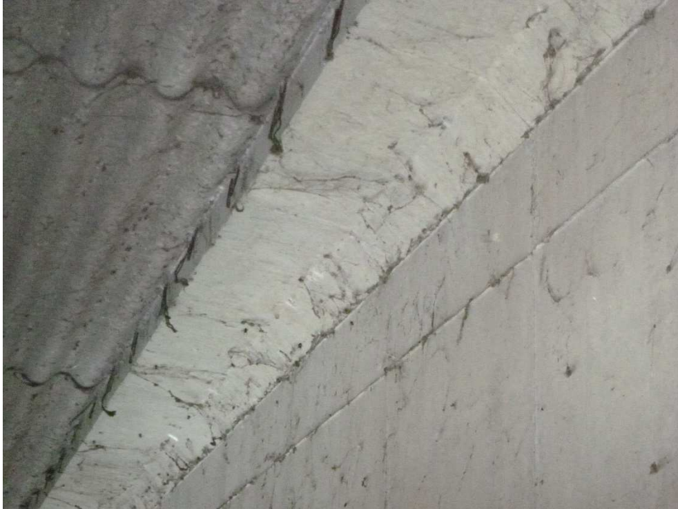
Figure 29 : pt2-points de calcite sous la semelle supérieure – coté amont
