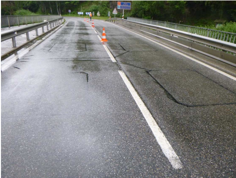
Figure 53 : Traits de scie et réparations sur milieu de chaussée
