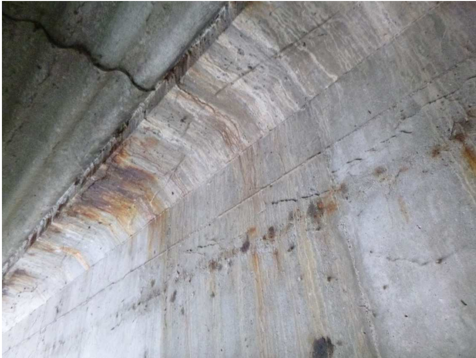
Figure 31 : pt3-points de corrosion en semelle supérieure, traces de calcite et de corrosion, fissure longitudinale avec éclat béton sur 8ml avec traces de corrosion – côté RD amont
